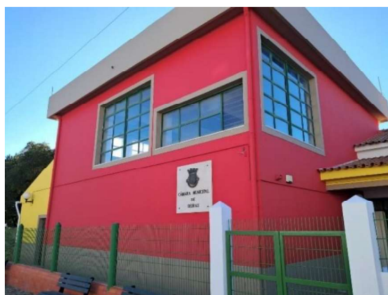
Fig. 185 - Pintura de fachada da EB São Bento
