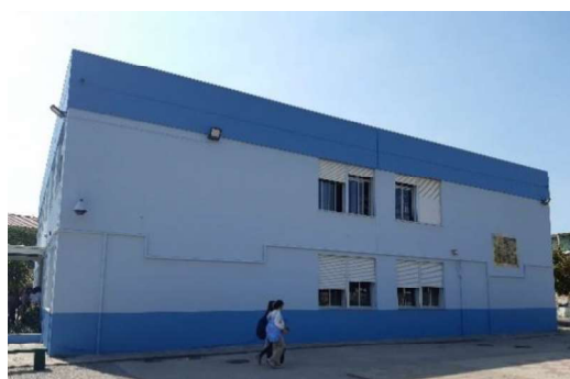
Fig. 177 - EB São Julião da Barra - Pintura de fachadas exteriores dos blocos A, C e D
