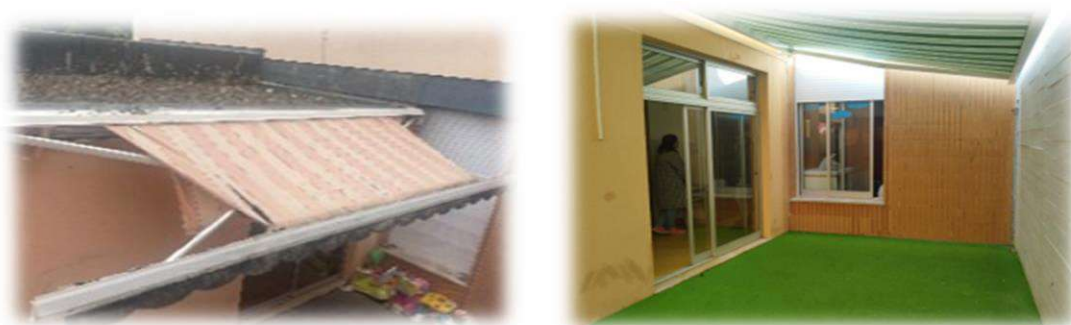
Fig. 155 - Requalificação do EJR da sala de aquisição de marcha Creche - JI Nossa Sra. do Acolhimento (antes e depois)
